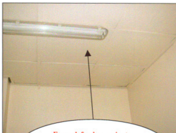
Faux-plafond en amiante-ciment dans le local batterie au RDC bât. St Pères (voir cartographie)
