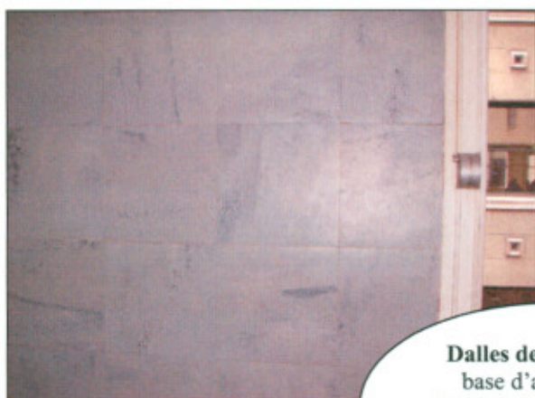
Colle noire à base d'amiante sous dalles de sol grises P1 Prélèvement : Bât. Jacob bureau 522
