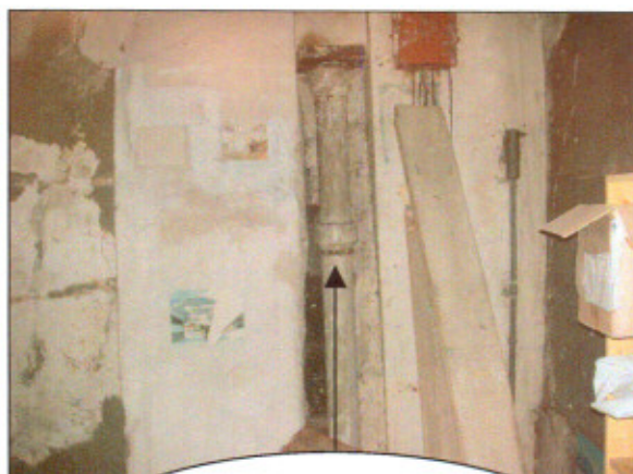
Conduit en amiante-ciment dans les combles du Bât. Eglise (voir cartographie)
