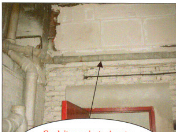
Conduit en amiante-ciment au dessus de la machinerie ascenseur n°3 au sous-sol bât. St Pères (voir cartographie)
