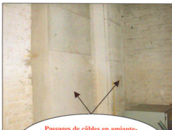
Passages de câbles en amiante-ciment dans le local S9 au sous-sol bât. St Pères (voir cartographie)
