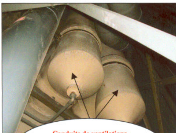
Conduits de ventilations circulaires en amiante-ciment dans les placards techniques tout niveau (voir cartographie)
