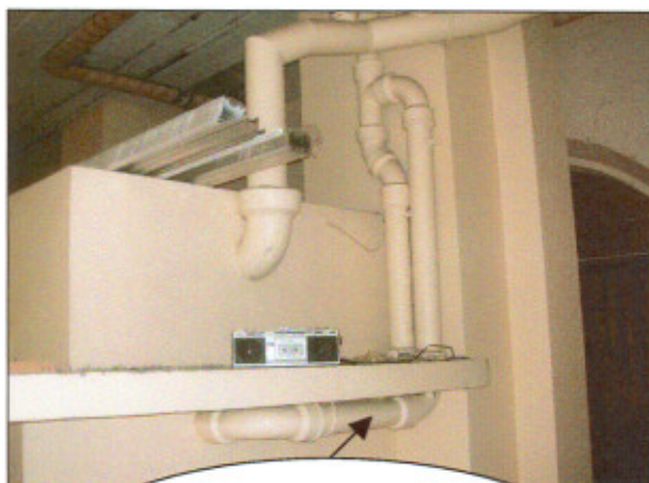
Conduits en amiante-ciment au quai de déchargement RDC bât. St Pères (voir cartographie)
