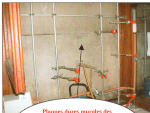
Plaques dures murales des sorbonnes en amiante-ciment dans les labos chimie bât. St Pères (voir cartographie)
