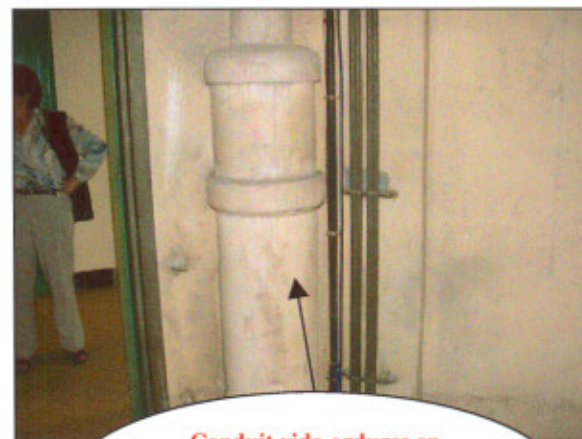
Conduit vide-ordures en amiante-ciment du 4 ème étage au sous-sol bât. St Pères (voir cartographie)
