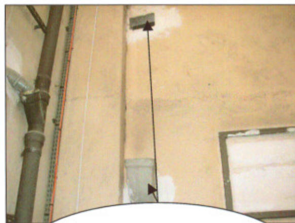
Conduits de ventilations de la trémie ascenseur en amiante- ciment dans le placard technique n°813 8ème étage (voir cartographie)
